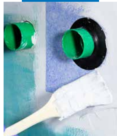
Mapei Rørmanchet, monteret i Mapegum WPS
