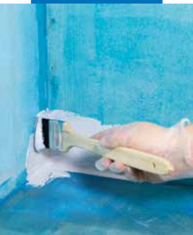
Montering af Mapei IC/EC hjørnemanchet ved hjælp af Mapegum WPS
