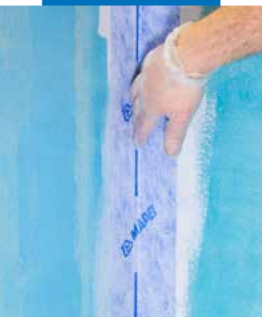
Montering af Mapei ST tætningssånd ved hjælp af Mapegum WPS på væg
