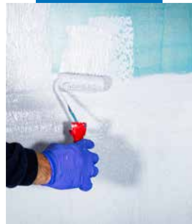
Påføring af Mapegum WPS membran med rulle
