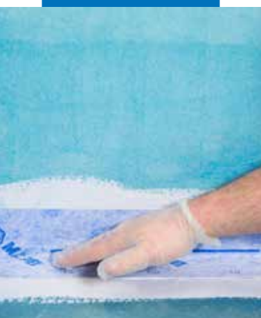
Montering af Mapei ST tætningssånd ved hjælp af Mapegum WPS på overgangen mellem gulv og væg
