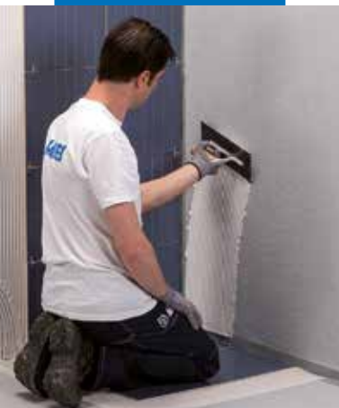
Påføring af fliselim
