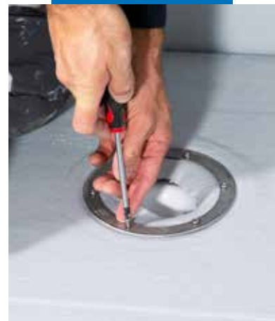
Butylmanchet (selvklæbende) lægges ned over afløbet (på færdig-primet gulv). Derefter påføres Mapegum WPS over manchetten og resten af gulvet
