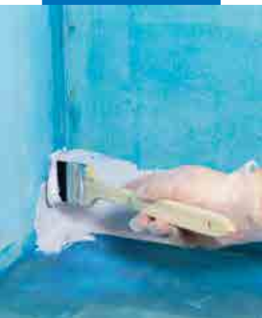
Indbygning af et Mapei IC/EC hjørne ved hjælp af Mapegum WPS
