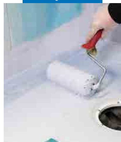
Påføring af Mapegum WPS med rulle
