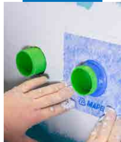
Indbygning af Mapei Rormanshett forsegling ved rørgennemføring med Mapegum WPS
