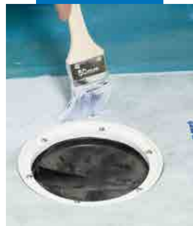
Butyl manchete (selvklæbende) ligges ned over afløb (på færdig primet gulv). Derefter påføres Mapegum WPS over manchete og over resten af gulvet
