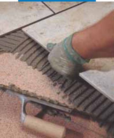
Einbrenndar flísar á terassóflísar á útvegg
