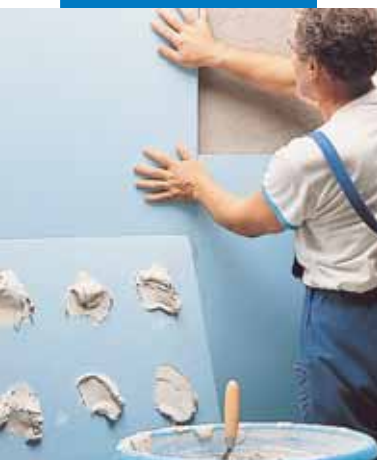
Lögn á froðuplastsplötum með hvítu Keraflex
