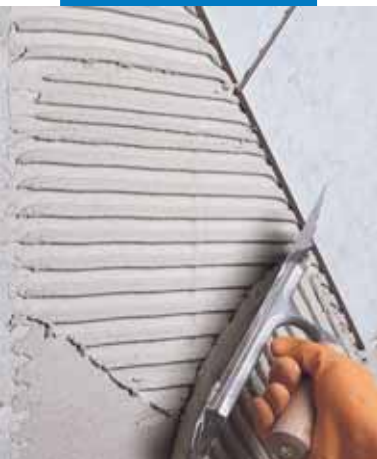
Lögn á einbrenndum flisum á vegg með froðuplasti
