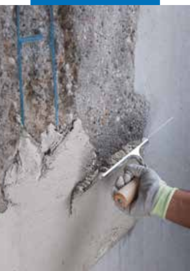
Planitop Smooth & Repair lagt út með múrbretti
