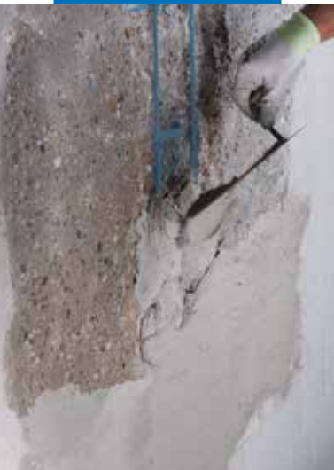
Planitop Smooth & Repair lagt út með múrskeld
