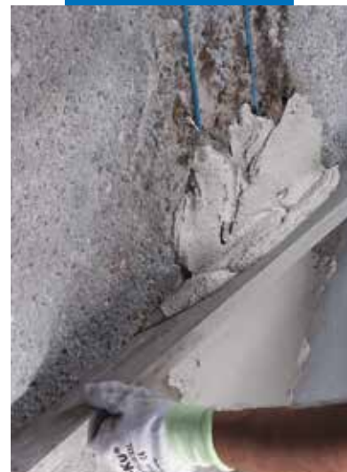
Jöfnun á Planitop Smooth & Repair með réttskeið
